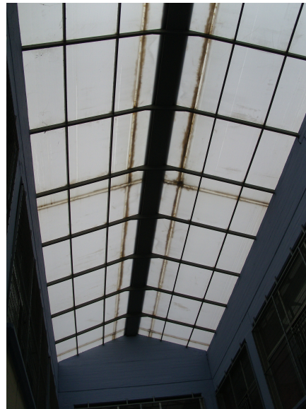
7. Επικάλυψη αιθρίου εσωτερικά
